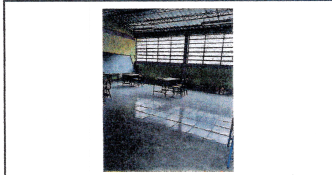
FOTO 4: INSTALACION DE PISO EN AULAS.
