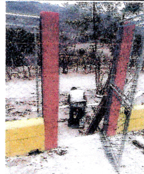
FOTO 4: CONTINUACION DE LA TORTA DE PATIO.
