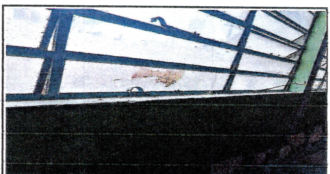
FOTO 4: MANTENIMIENTO Y REPARACION DE VENTANAS ROTAS.
