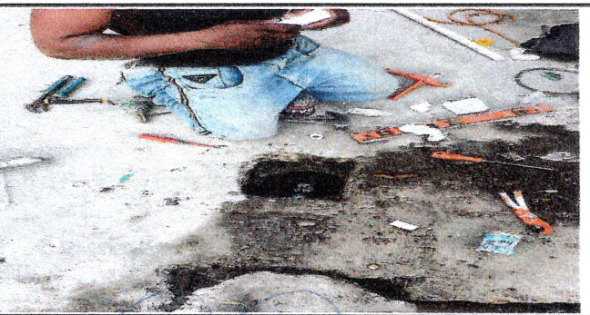
Foto 6: Reparación de drenajes y agua potable.
