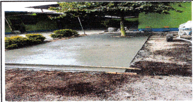
Foto 7: Losa en el patio.
