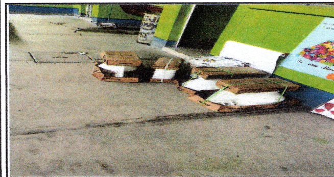
Foto 5: Cambio de sanitarios con accesorios.
