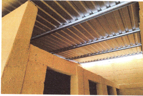
Foto1: cubierta de lamina y estructura de techo
