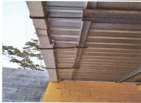
Foto: 6 canales y bajadas de agua fluvial
