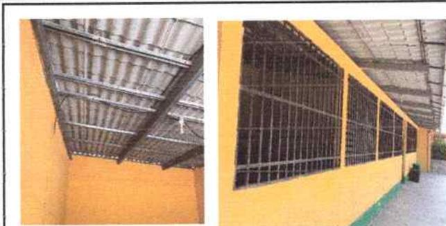
Foto 2: Cubierta de lámina y estructura de techo, levantado de 30 cm de pared
