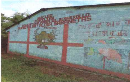
Foto 3: PINTURA EN MUROS INTERIORES Y EXTERIORES
