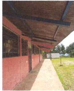
Foto 2: ESTRUCTURA DE TECHO
