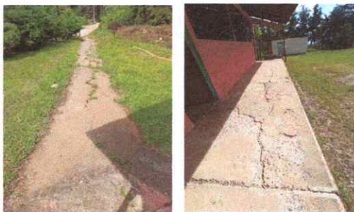
Foto 5: LOSA DE PATIO
