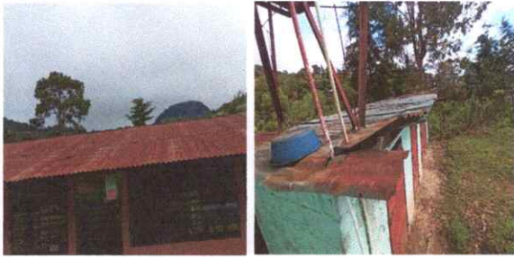
Foto1: CUBIERTA DE LAMINA
