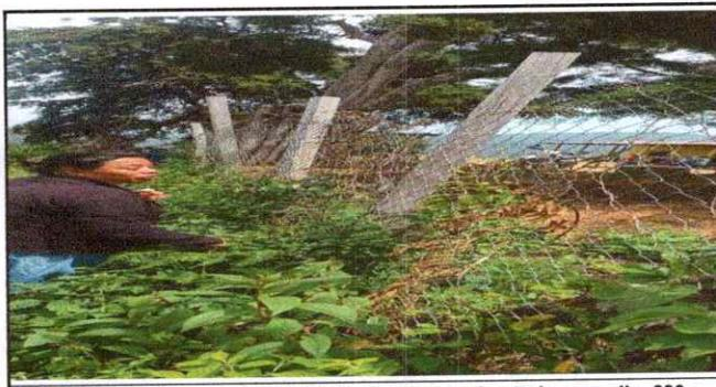
Foto 5: Reparacion y mantenimiento de cerco perimetral con malla 200 mts2
