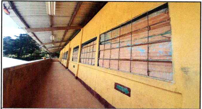
Foto 2: VENTANALES SEGUNDO NIVEL
