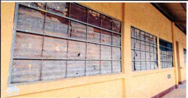
Foto 6: VENTANALES DE ENTRADA AL CENTRO EDUCATIVO
