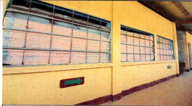
Foto 1: VENTANALES SEGUNDO NIVEL
