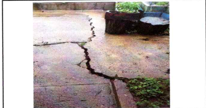
Foto 4: LOSA DE PATIO
