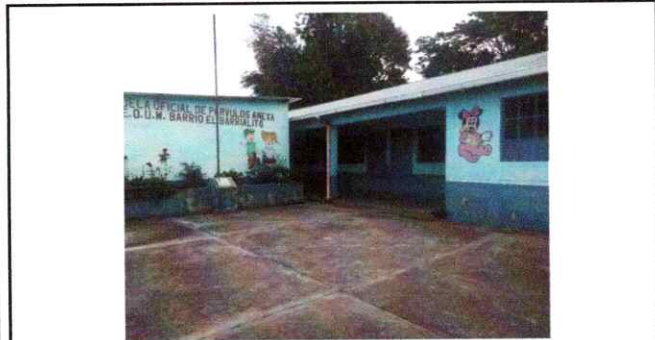
Foto1: PINTURA EN MUROS INTERIORES Y EXTERIORES
