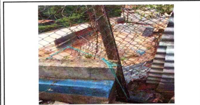
Foto 3: CERCO DE MURO PERIMETRAL
