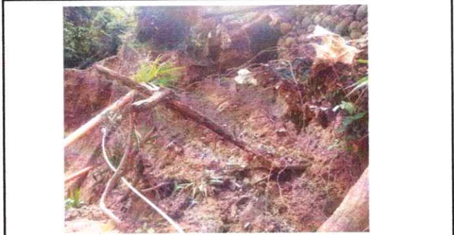
Foto 2: REPARACION DE RED DE DRENAJES Y RED DE AGUA POTABLE
