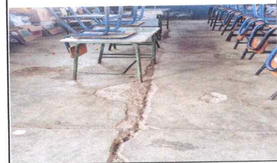
FOTO 5.1: SUSTITUCION PISO CERAMICAS.
