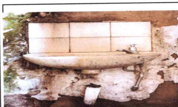
FOTO 7.2: SUSTITUCION DE LAVAMANOS CON PEDESTAL.
