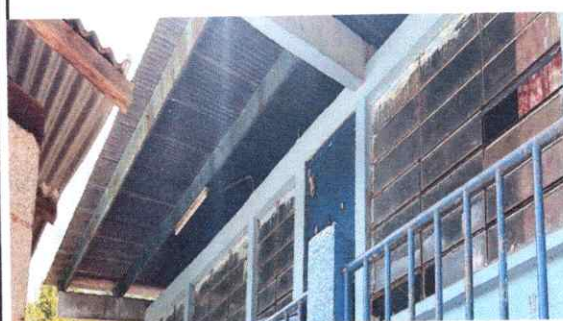
FOTO 4.1: SUSTITUCION DE CANALES Y BAJADAS 4".
