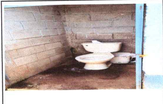
FOTO 7.1: SUSTITUCION DE SANITARIOS COMPLETOS.
