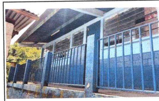
FOTO 8.1: REPARACION Y MANTENIMIENTO A BARANDA.
