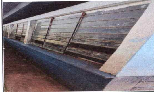
FOTO 4.1: SUSTITUCION DE VIDRIOS MEDIDAS TÍPICAS.
