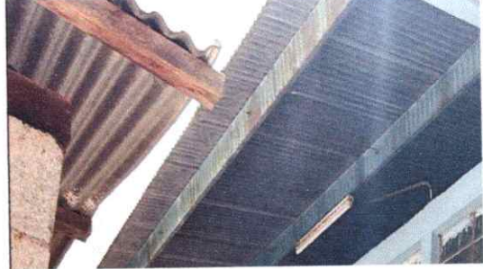
FOTO 2.1: REPARACION Y MANTENIMIENTO DE ESTRUCTURA.
