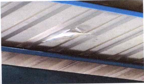
FOTO 1.1: SUSTITUCION LAMINA TROQUELADA CALIBRE 26
