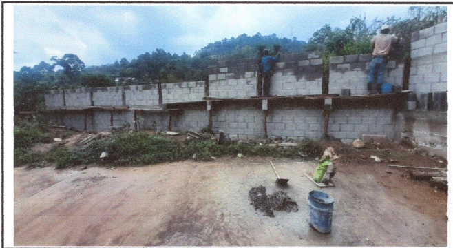
FOTO 3 : AVANCE CERCO PERIMETRAL
