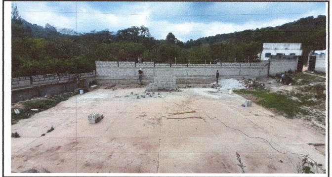
FOTO 2 : SE OBSERVA AVANCE DEL CERCO PERIMETRAL
