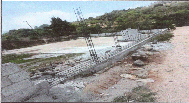
FOTO 1 : SE OBSERVA EL AVANCE DEL MURO DE CONTENCIÓN
