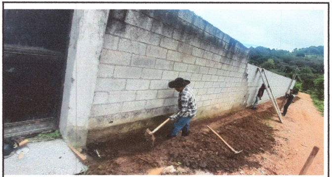
FOTO 4 : AVANCE DE CUNETETA DE CONCRETO EXTERIOR
