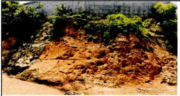
Foto1: Reparación de muro de contención.
