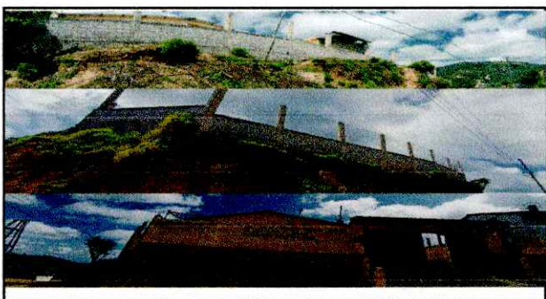
Foto 4: Pintura de muro Perimetral Exterior.
