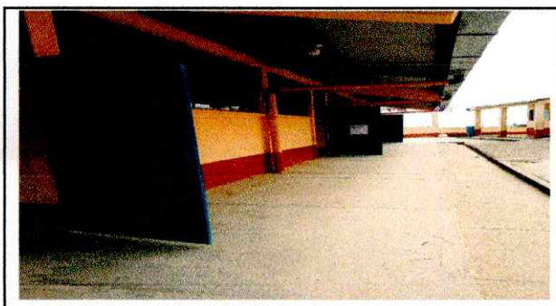
Foto 3: Modificación de puertas(cambio de posición).
