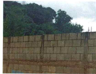
Foto 2: pintura en muros interior y exterior
