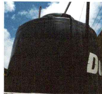
Foto 10: reparación y mantenimiento/ deposito de agua
