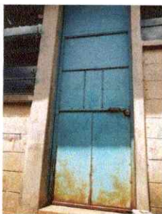
Foto 11: puertas (mantenimiento de pintura)
