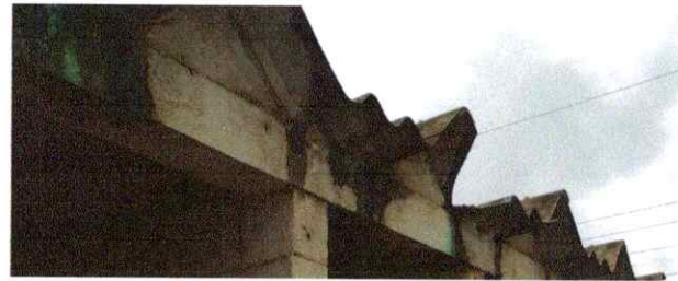
Foto 4: cubierta de lamina y estructura de techos para baños
