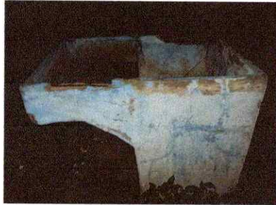
Foto 7: sustitución de pila
