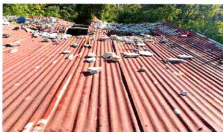
Foto 5: TECHO EN MAL ESTADO, CON RIESGO DE COLAPSO
