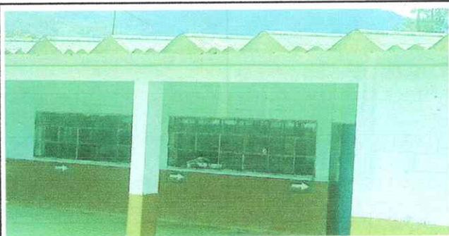
Foto 5: PINTURA EN MURO EXTERIOR E INTERIOR
