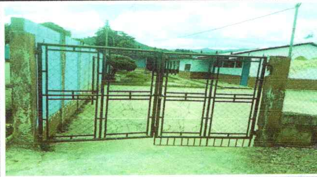
Foto 4: MANTENIMIENTO A PORTONES
