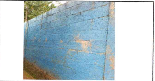
Foto 5: Pintura en muros interior y exterior
