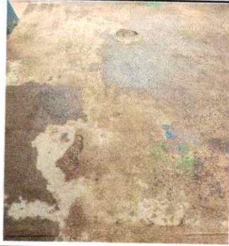
Foto 7: Losa de patio
