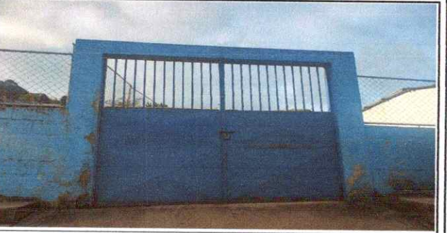
Foto 6: Mantenimiento a portones.
