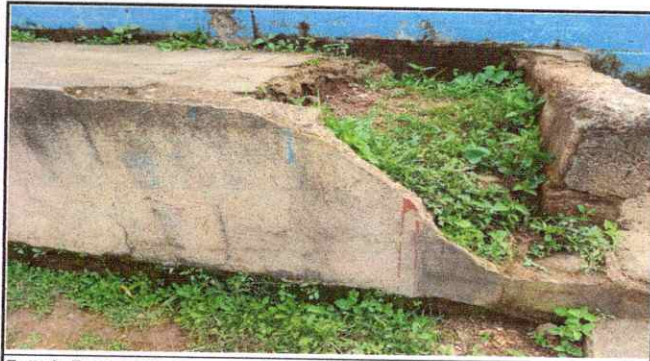
Foto 9: Reparación de muros de contención.
