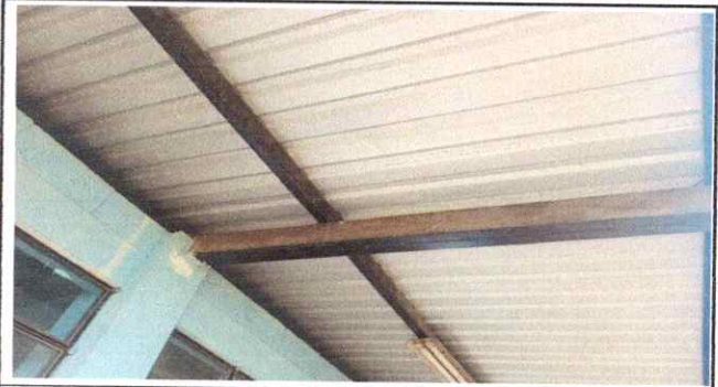
Foto 2: Estructura de techo
