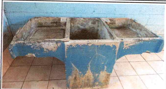
Foto 8: Reparación o sustitución de área de cocina (estufas rurales, pilas, ventanas, puertas. Chimeneas, etc)
