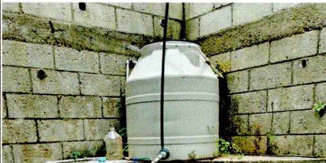
Foto 3: REPARACION Y MANTENIMIENTO DE CISTERNAS/DEPOSITOS DE AGUA
