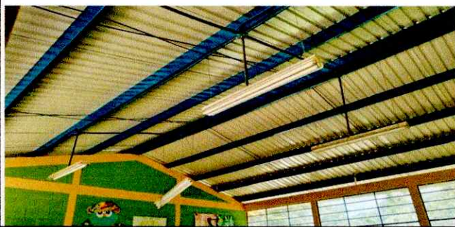
Foto 5: REPARACION SISTEMA ELECTRICO
