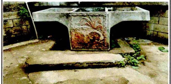
Foto 4: REPARACION O SUSTITUCION DE AREA DE COCINA (ESTUFAS RURALES, PILAS, VENTANAS, PUERTAS, CHIMENEAS, ETC)
