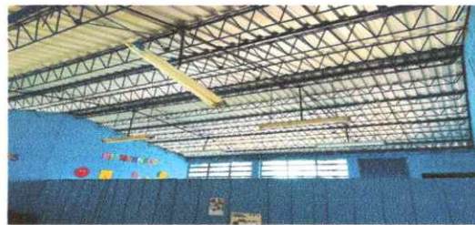
Revisión y reparación del sistema eléctrico
