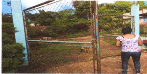
Sustitución de portón de reja con hierro legítimo y proceso 4M2 X2.20
