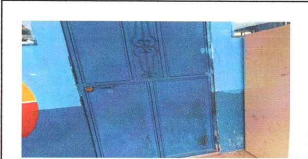
Reparación y mantenimiento area aulas
