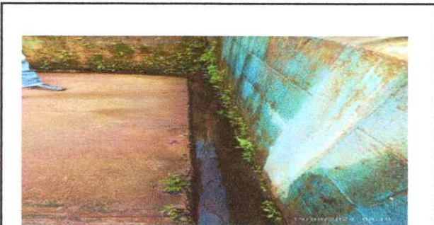
Sustitución de cuneta de concreto
