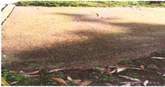
Sustitución de losa de patio incluye base, fundición y acabado ingreso al patio)
