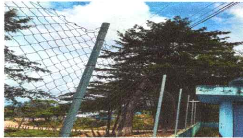
Sustitución de cerco perimetral 78 M2
