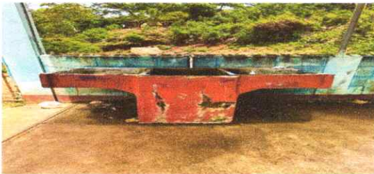
Sustitución de pilas
