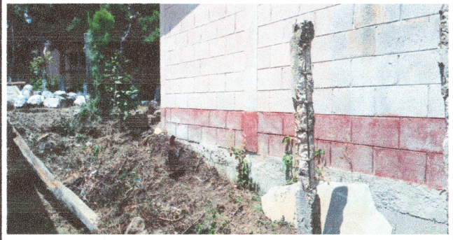
Foto 2: Cercos de muro
