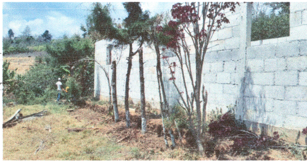
Foto 3: Cercos de Muro
