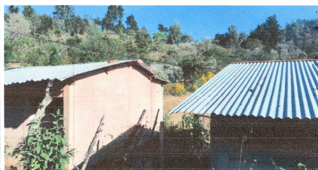
Foto 2: Cubierta de Lamina.
