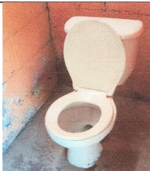
Foto 3: Reparación de Sanitario.
