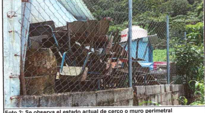
Foto 2: Se observa el estado actual de cerco o muro perimetral
