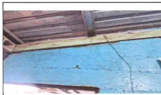
Foto 6: Reapación de Sistema Electrico
