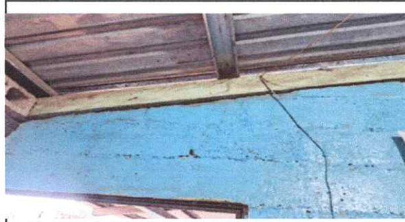
Foto 2: Estructura de techo
