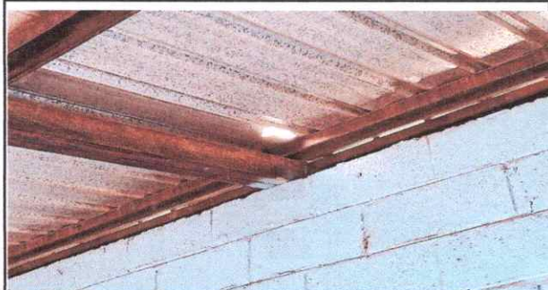
Foto 1: Cubierta de Lámina
