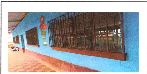
Sustitución de pintura base agua
