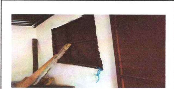
Reparación de ventanas
