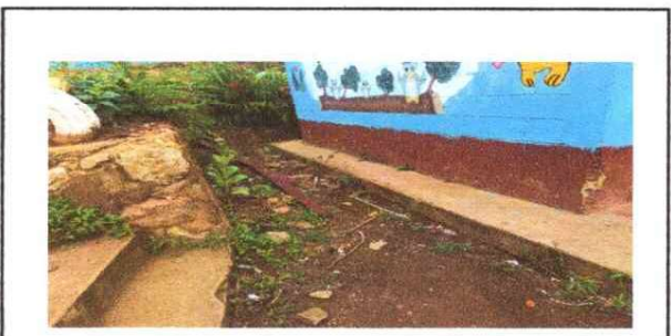
Sustitución de pintura base aceite (socalo)
