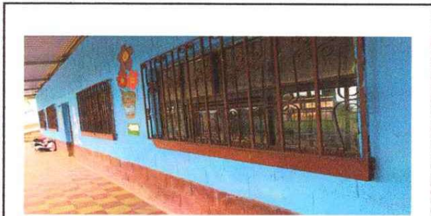
Reparación y mantenimiento en ventanas, pintura, silicón y limpieza de vidrios
