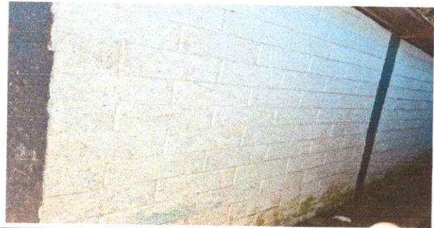
Foto 4: PINTURA EN MUROS INTERIOR Y EXTERIOR
