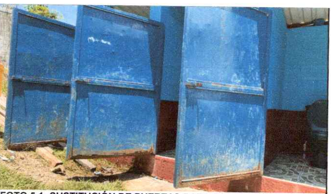
FOTO 5.1: SUSTITUCIÓN DE PUERTAS PARA SANITARIOS
