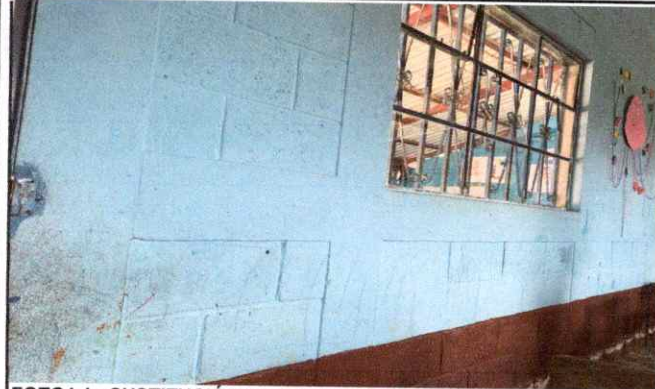
FOTO 1.1 : SUSTITUCIÓN DE PINTURA BASE ACEITE
