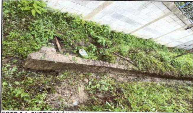
FOTO 6.1: SUSTITUCIÓN DE CUNETAS DE CONCRETO DE 25X30X25 CM
