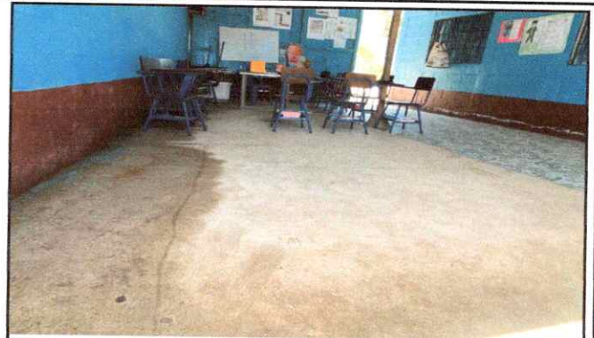
FOTO 2.1: SUSTITUCIÓN DE PISO CERAMICO ANTIDESLIZANTE CON ZOCALO.
