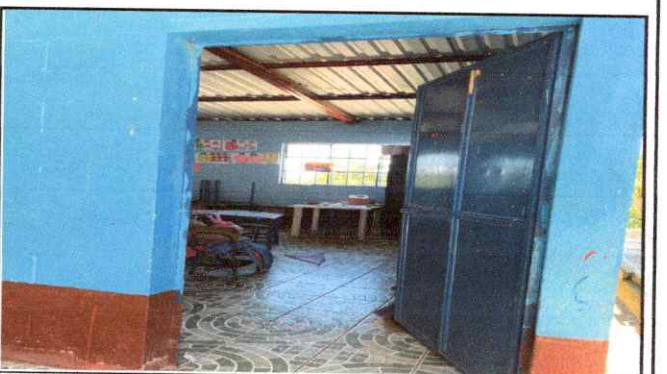
FOTO 5.2: MANTENIMIENTO, REPARACIÓN Y CAMBIO DE CHAPA PUERTA DEL AULA.
