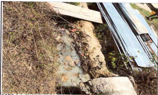
FOTO 3.1: SUSTITUCION DE DRENAJE, ESCABACION, NIVELACION E INSTALACION TUBO DE CEMENTO DE 24" CM DE DIAMETRO
