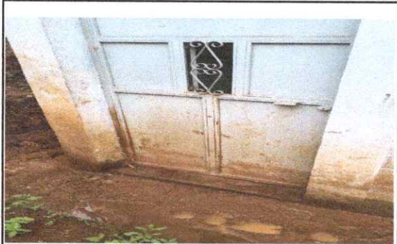
FOTO 1.1: REPARACION Y MANTENIMIENTO PUERTAS EN AREA DE AULAS.
