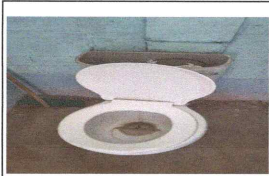
FOTO 4.1: SUSTITUCION DE SANITARIOS COMPLETOS.
