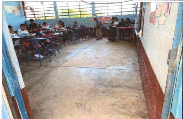
FOTO 2.1 SUSTITUCIÓN DE PISO CERAMICO ANTIDESLIZANTE CON ZOCALO, (SE RETIRARÁ LO EXISTENTE, NIVELACIÓN Y FUNDICIÓN DE BASE PARA LA COLOCACIÓN DEL PISO)
