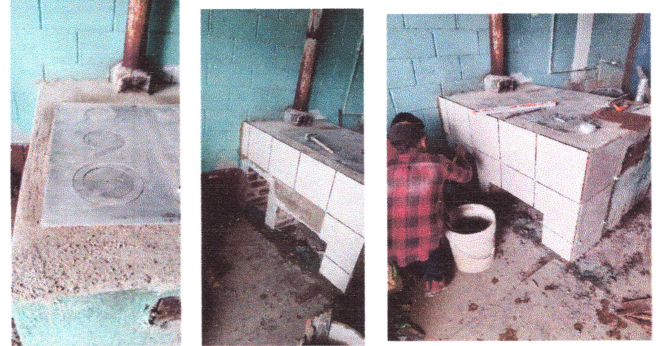
Foto 8: REPARACION (ESTUFAS RURALES, PILAS, CHIMENEAS, ETC.)
