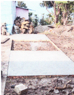
Foto 5: FUNDIR 38.4 METROS CUADRADOS DE LOSA DE PATIO CON UN ESPESOR DE 8 CM, TALLADOS.
