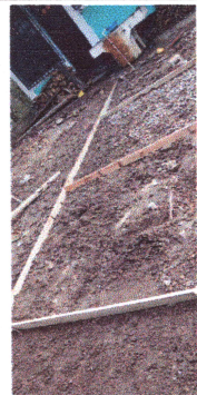
Foto 5: FUNDIR 38.4 METROS CUADRADOS DE LOSA DE PATIO CON UN ESPESOR DE 8 CM, TALLADOS.
