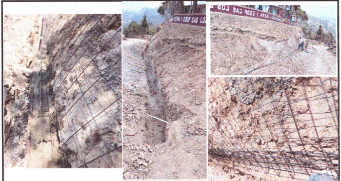
Foto 10: REBESTIMIENTO DE CONCRETO EN TALUD CON ELECTROMALLA Y ENSABIETADO A LA SUPERFICIE DEL TERRENO NATURAL.
