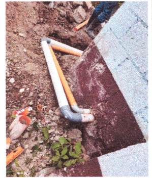
FOTO 2: INSTALACION DE TUBERIA PARA LA INSTALACION DE LOS NUEVOS BAÑOS.
