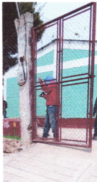
Foto 3: SE LE DARA MANTENIMIENTO AL PORTON DE INGRESO MEDIANTE PINTURA ANTICORROSIVA.
