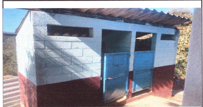
FOTO 2: REMPLAZO DE DOS SANITARIOS NUEVOS CON SUS ACCESORIOS.
