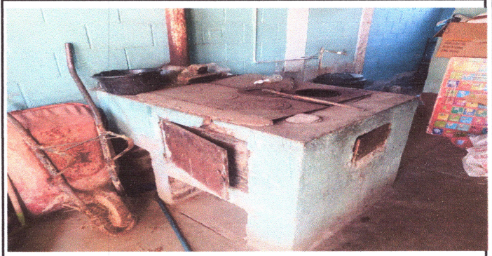
Foto 8: REPARACION (ESTUFAS RURALES, PILAS, CHIMENEAS, ETC.)
