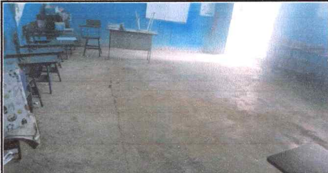
Foto 4: sustitución de piso de granito incluyendo base.
