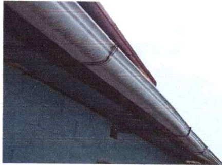
Foto3: CANALES Y BAJADAS DE AGUA PLUVIAL
