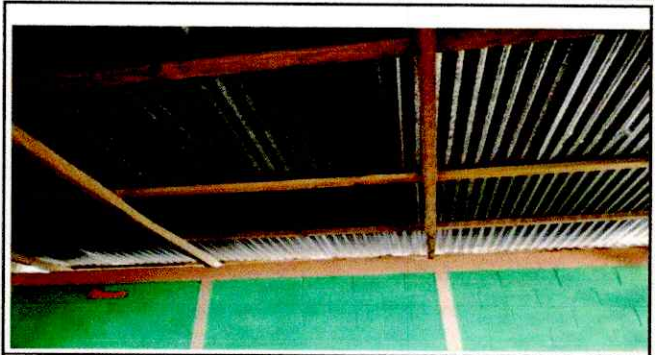
Foto 2: ESTRUCTURA DE TECHO
