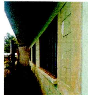
Foto 4: MANTENIMIENTO A BARANDAS
