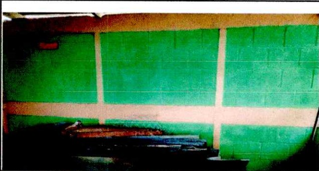
Foto 5: PINTURA EN MUROS INTERIOR Y EXTERIOR
