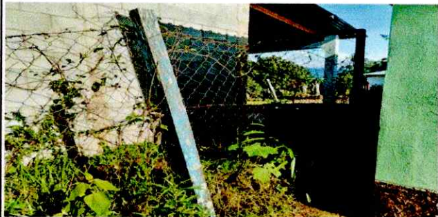
Foto 1: CERCO O MURO PERIMETRAL
