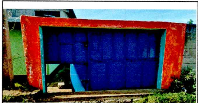
Foto 6: MANTENIMIENTO A PORTONES
