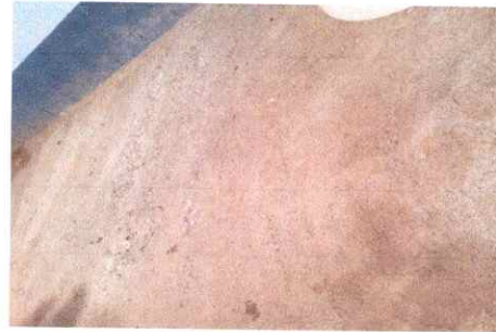
Foto 8: Losa de patio
