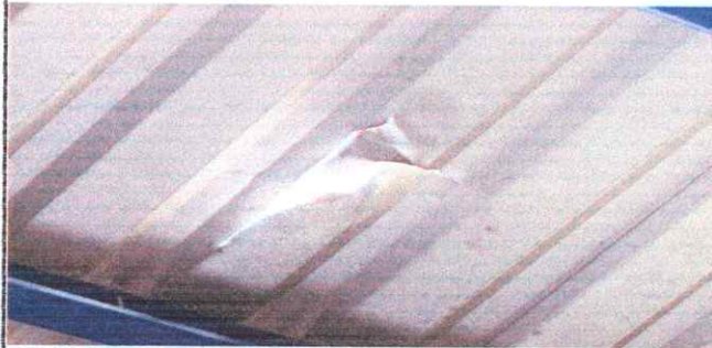
FOTO 1.1: SUSTITUCION LAMINA TROQUELADA
