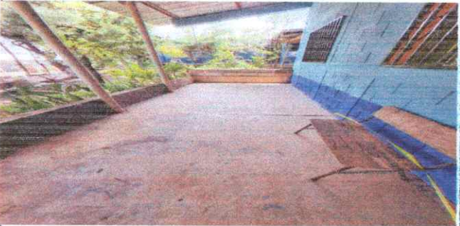
FOTO 3.1: SUSTITUCION PISO CERAMICO.
