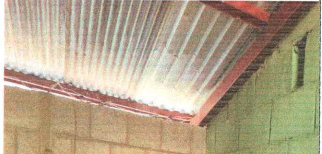
FOTO 2.1: SUSTITUCION ESTRUCTURA DE TECHO.
