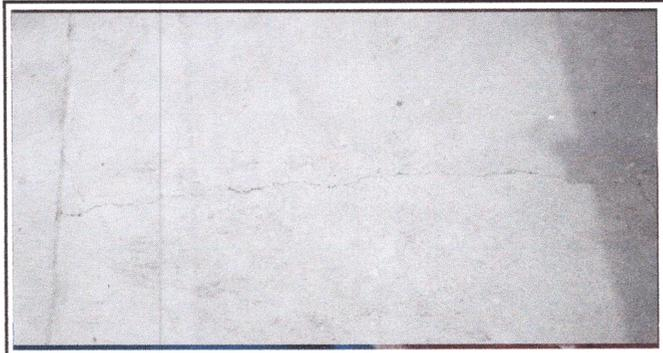
FOTO 2: colocación de piso de granito por torta levantada
