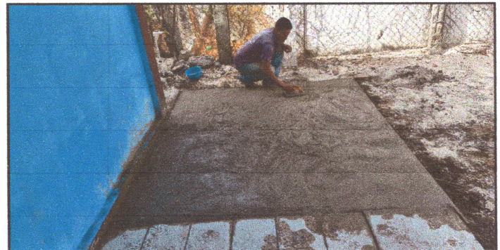
Foto: 6 reparación de torta para instalar piso
