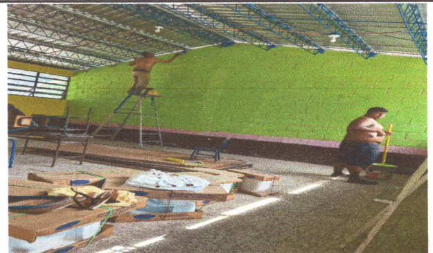
Foto4: Pintura muros interior y exterior
