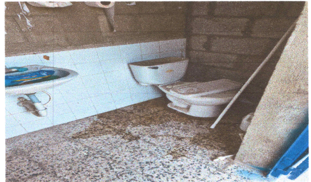
FOTO 2: Reparación de sanitarios
