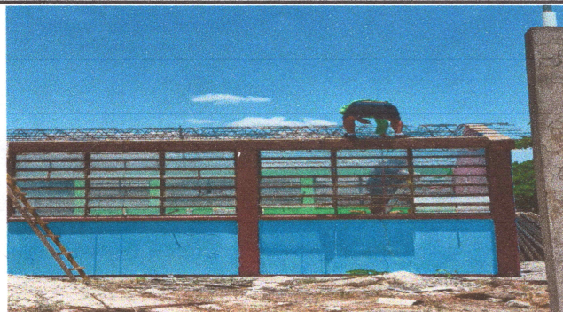
Foto3: quitado de duralita para instalar estructura de techo
