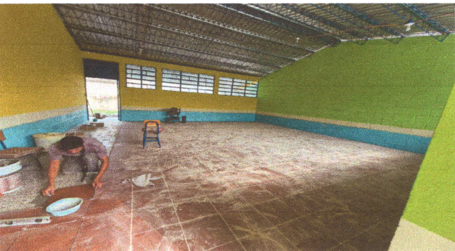
Foto: 5 Colocación de piso
