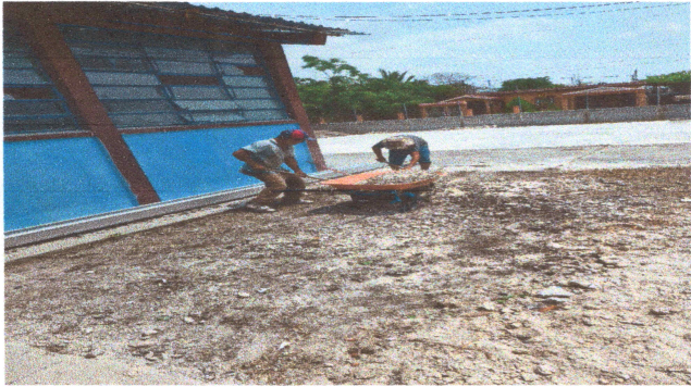
Foto1: Removiendo loza de patio en mal estado preparando para hechar nueva loza
