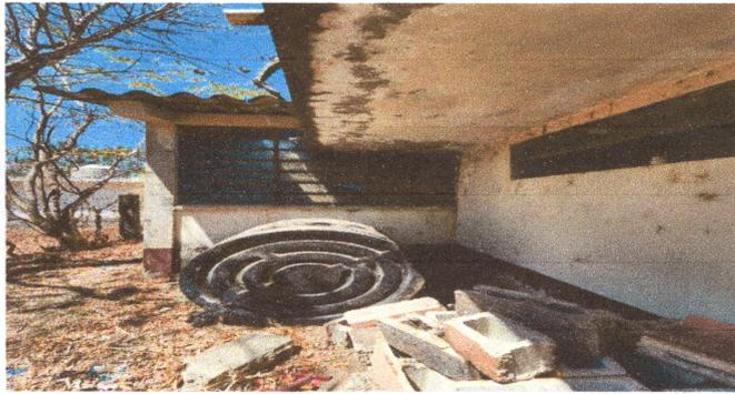
Foto1: Cisterna en mal estado la cual se callo por deterioro
