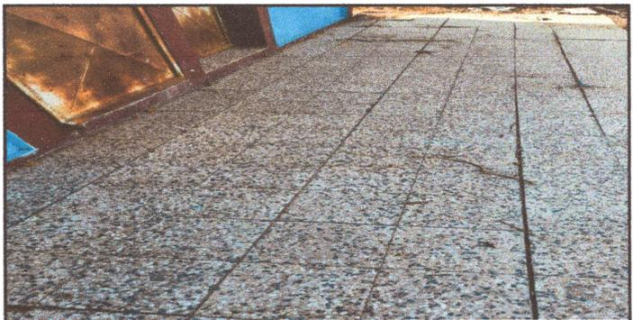
Foto 6 piso levantado y en mal estado
