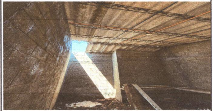
FOTO 2: Estructura y techo en mal estado techo existente duralita
