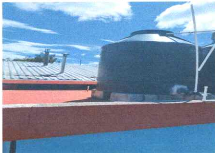
Foto 3: Reparación deposito de agua
