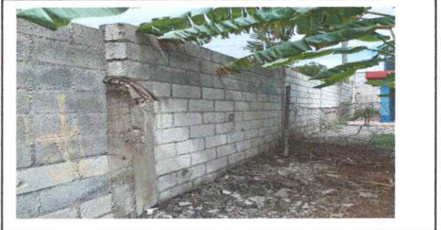
Foto 2: Reparación muro de contención
