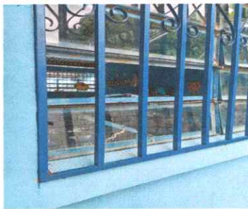
Foto 5: Reparación ventanas de 0.40 x 0.60
