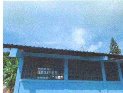
Foto 2: Canales y bajada de agua pluvial
