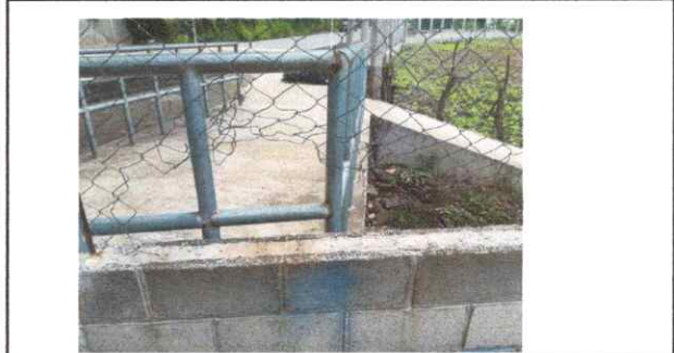
Foto 1: Cerco muro perimetral
