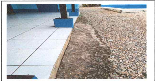
Foto 3: cuneta de concreto
