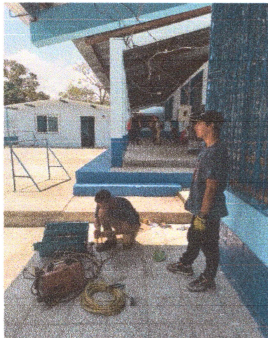
Foto 3: Reparación de sistema eléctrico en proceso.
