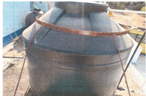
Foto 4: Reparación y mantenimiento de cisternas/ deposito de agua en proceso.
