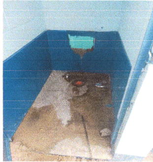
Foto 1: Servicio sanitarios y sus accesorios en proceso.
