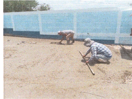
Foto 2: Losa de patio en proceso.
