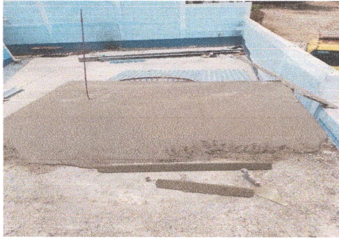
Foto 1: Impermeabilización de losa en proceso.
