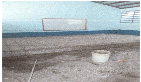
Foto 4: Piso en proceso.
