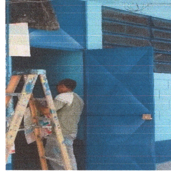
Foto 2: Puertas en proceso.
