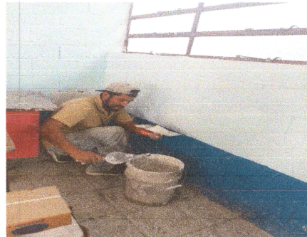
Foto 6: Reparación de repello y cernido de paredes en proceso.
