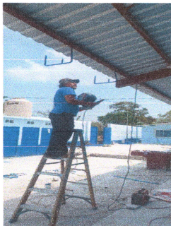
Foto 5: Canales y bajadas de agua pluvial en proceso.
