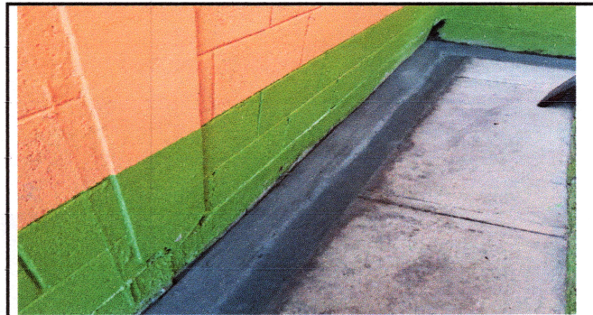
Foto4: Cunetas obstruidas y en mal estado. Reparadas, reconstruidas, limpias.
