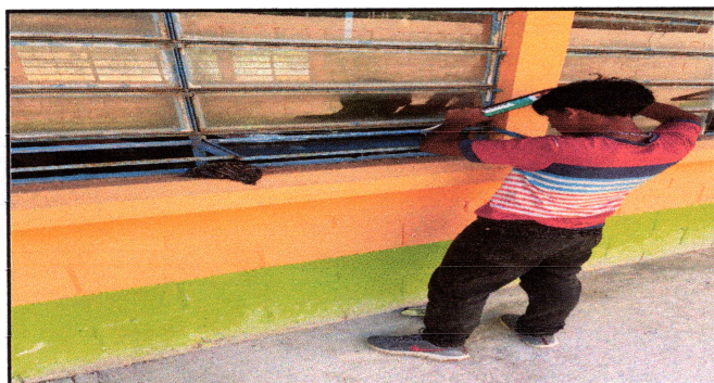
Foto3: Reparando vidrios rotos, flojos y sucios de ventanales.
