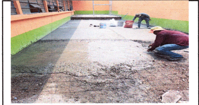
FOTO 10: Reparación de losa de patio con grietas y quebraduras.
