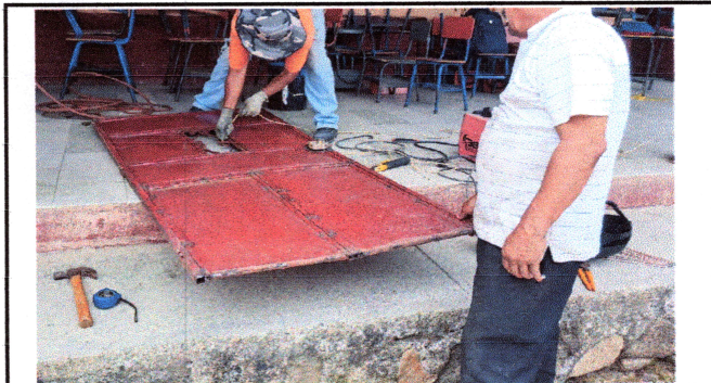
FOTO 2: Reparación de puertas oxidadas y corrosionadas.
