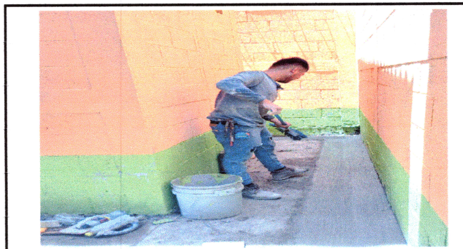
Foto4: Reparación de cunetas obstruidas y en mal estado.
