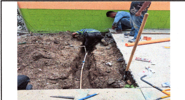
FOTO 9: Desobstrucción de red de drenaje y agua potable.
