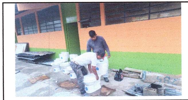
Foto: 6: Sustitución de sanitarios y sus accesorios.
