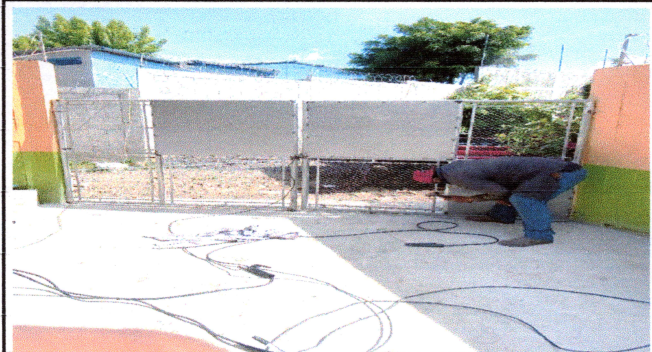
FOTO 7: Reparación de portón de entrada corrosionado.
