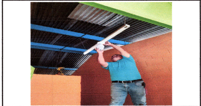
FOTO 8: Sustitución y reparación de Impara squemadas, en mal estado.
