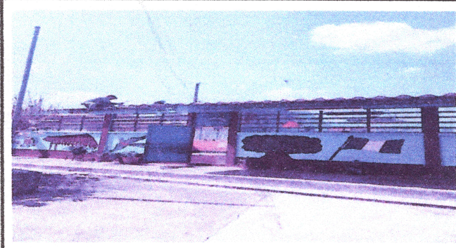
Foto1: Reparación del techo
