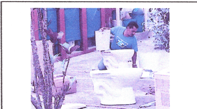
Foto3: Instalación de Sanitarios
