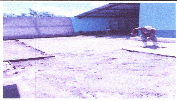
FOTO 2: Reparación Losa de Patio
