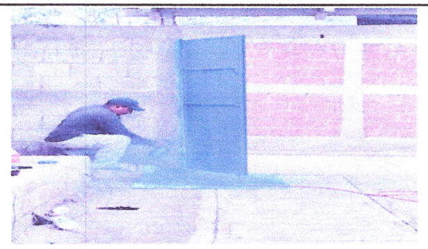
Foto4: Mantenimiento pintura porton
