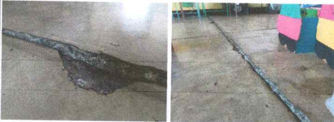
Foto 1: Sustitución de piso de 3 aulas 7.40 x 8.50
