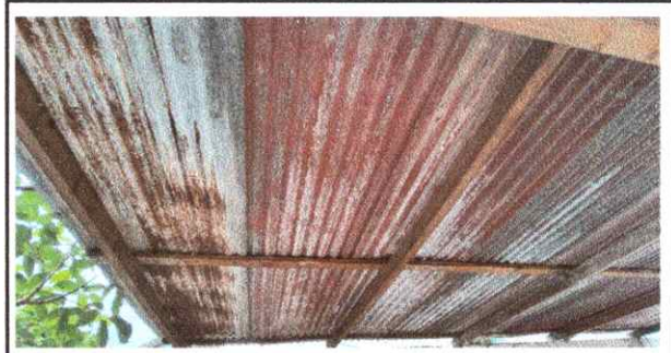
Foto 2: SUSTITUCIÓN ESTRUCTURA DE TECHO
