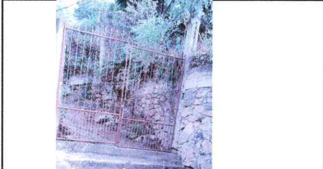
Foto 8: SUSTITUCIÓN DE PORTON CON TUBO CON LÁMINA LISA
