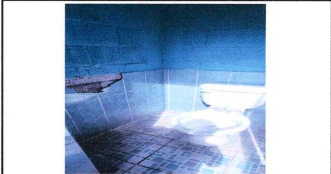
Foto 9: SUSTITUCIÓN DE AZULEJO (AREA DE BAÑO)
