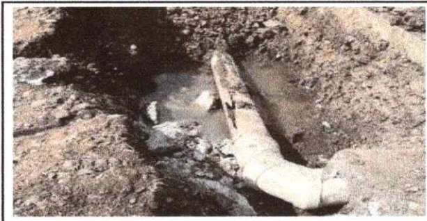
Foto 3: REPARACIÓN DE RED DE DRENAJE Y AGUA POTABLE.
