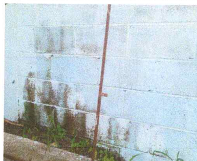
Foto 4: PINTURA EN MUROS INTERIOR Y EXTERIOR (Sustitución adentro y afuera)
