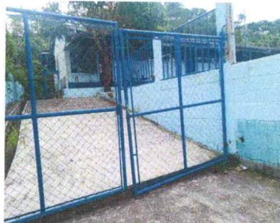
Foto 5: MANTENIMIENTO A PORTONES (Reparación)
