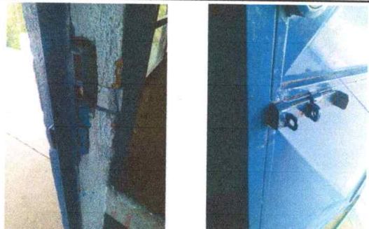
FOTO 1: PUERTAS (remozamiento reparar y pintar)
