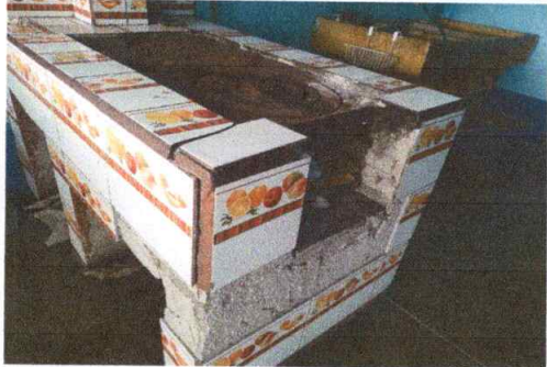
FOTO 8: REPARACIÓN O SUSTITUCIÓN DE AREA DE COCINA (Cambio Pila, Estufas rurales, Ventanas, Puertas, Piso)
