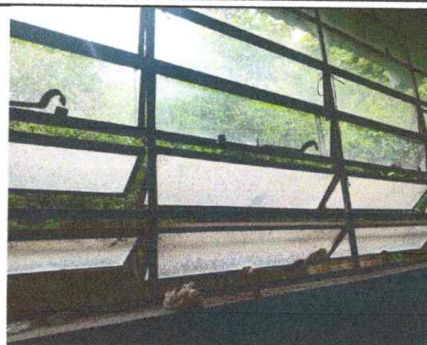
FOTO 2: VENTANAS (Reparación y mantenimiento, metal, pintura y vidrios)
