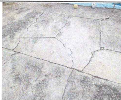
Foto 6: LOSA DE PATIO (Sustitución demolición, base, fundición y acabado)
