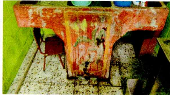
FOTO 9: CAMBIO DE PILA
