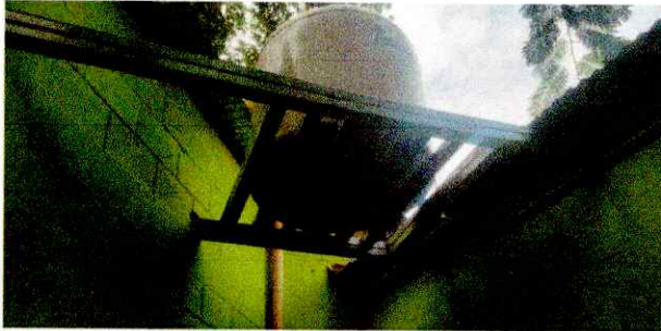
Foto8: BASE ROTOPLAS CON COLUMNA DE CEMENTO
