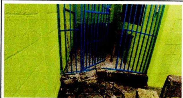
Foto 4: MANTENIMIENTO A BARANDAS
