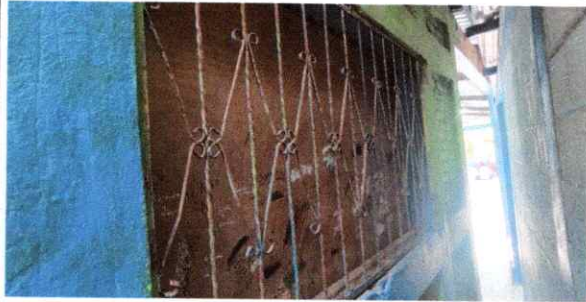
Foto1: SUSTITUCIÓN DE VENTANAS
