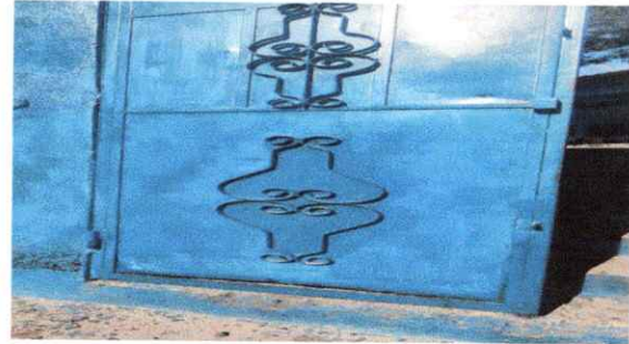
Foto 4: SUSTITUCIÓN DE PORTON
