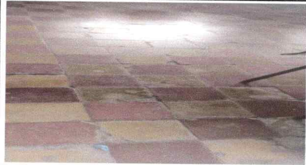
Foto 2: SUSTITUCIÓN PISO GRANITO
