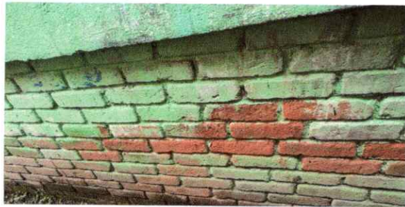
Foto 3: PINTURA EN MUROS INTERIOR Y EXTERIOR
