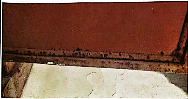
Foto1: REPARACIÓN DE PUERTAS DE BAÑO
