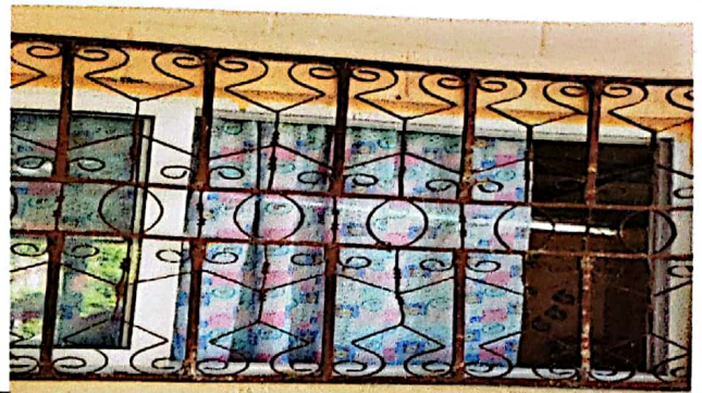
FOTO 2: REPARACION DE BALCONES
