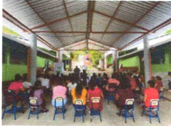
Foto 1: CUBIERTA DE LAMINA (SUSTITUCION LAMINA TROQUELADA CALIBRE 26)
