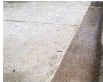
Foto 6: CUENTA DE CONCRETO (DEMOLER Y FUNDIR)
