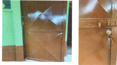
Foto 2: PUERTAS (REPARAR, PINTAR, CAMBIAR CHAPAS)
